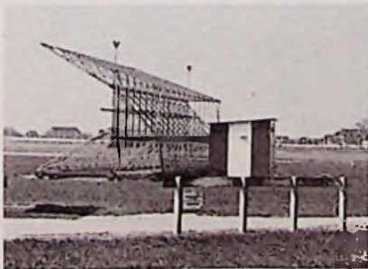
Afb. 10 Koerslijn-zender (Localizer) antenne voor CAT III op Schiphol.
